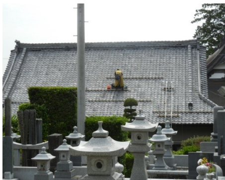
瓦工事 作業風景
