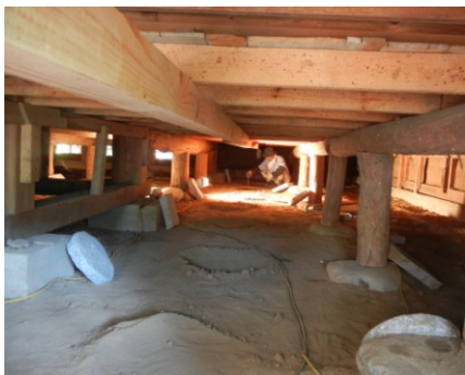
低所での作業は一日中しゃがんで行う、厳しい作業です。
