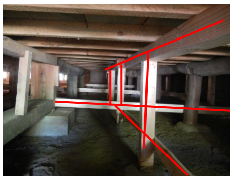
赤い線のように柱を補強しました
